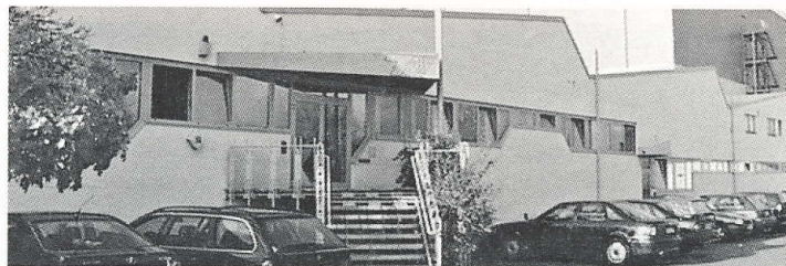
Textilauflbereitung Weser Nord GmbH und im Hintergrund die Lagerhalle der Textil-Logistic-Zentrum GmbH in Bremerhaven am Grauwallring
