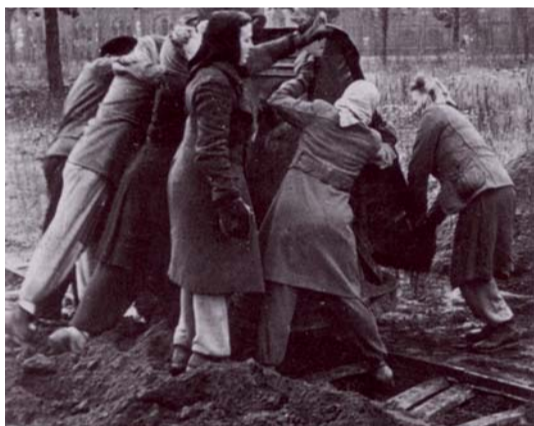
Nach dem Kriegsende war die Stadt Friedrichshafen zu 70% zerstört. Das Fabrikgelände der Firma Maybach ebenso. Wieder ein mal waren es die Mitarbeiter, vorwiegend Frauen, die den Karren buchstäblich aus dem Dreck zogen.
